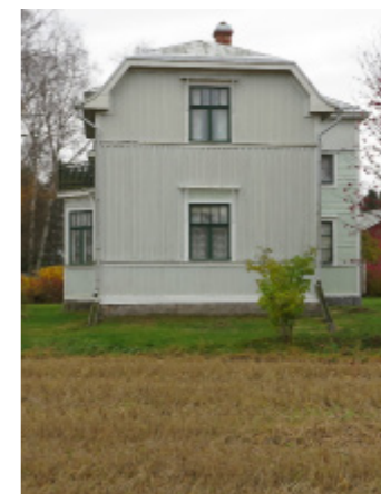
Östra och västra fasaden på Tuvasvägen 373. Den fullhöga kvisten har grundats på samma stenfot som byggnaden i övrigt.
