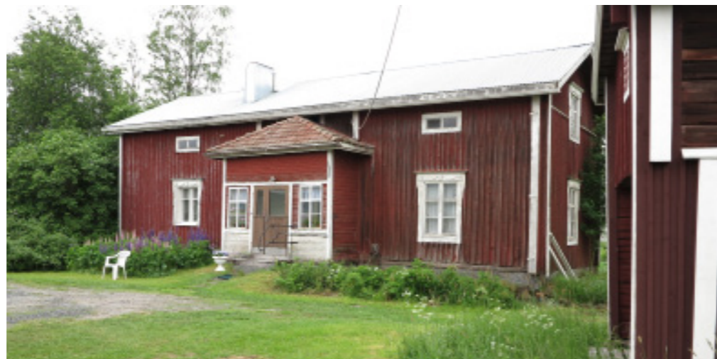
Objekten vid Norrvägen i Petalax har fått nytt plåttak och sockelbeklädnad och kvisten vid Sadelidvägen i Norra Pörtom har fått nya dörrar, den rappade kvisten har en stomme av trä..
