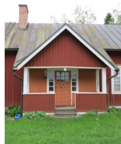
Kvisten från Yttermalax Åminnevägen 98 är dels öppen och slutna. Taket fortsätter över kvisten och en fronton finns ovanför den.
