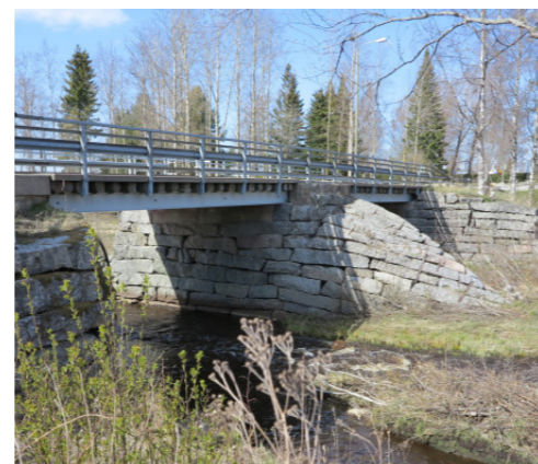
Kyrkbron byggdes år 1888. De av kilade stenar lagda brokistorna har motstått vårisarnas tryck i 125 år. Mittkistan är spjutformad för att klyva isen.
