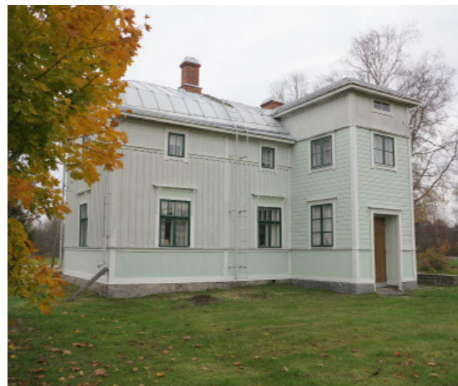
Östra och västra fasaden på Tuvasvägen 373. Den fullhöga kvisten har grundats på samma stenfot som byggnaden i övrigt.
