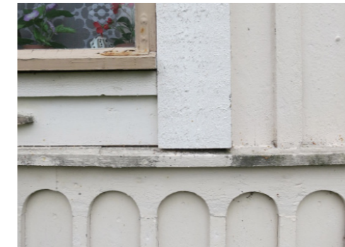
Fönsterfoder, hängbräder etc. borde alltid göras av hyvlat virke. Ett ohyvlat bräde framträder i fasaden till vänster i bild.
